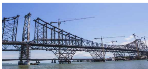
Estruturas metálicas da ponte Hercílio Luz que serão usadas nas pontes metálicas
