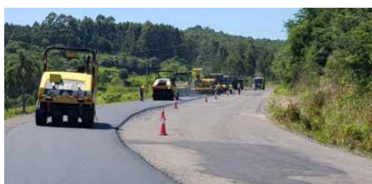
Construção da Rodovia SC-467, trecho Jaborá-Ouro
