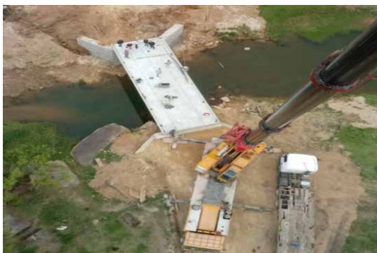
Montagem de kit de transposição de obstáculos pela Defesa Civil de Santa Catarina
