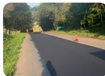
Intervenção funcional na Rodovia SC-464, entre Salto Veloso e Arroio Trinta
