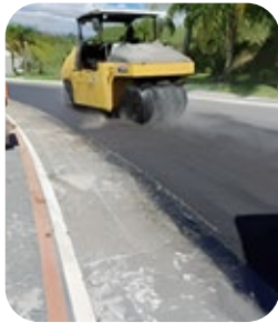
Intervenção funcional na Rodovia SC-281, entre Atalanta e Agrolândia
