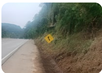
Limpeza de drenagem na Rodovia SC-350, em Rio do Sul
