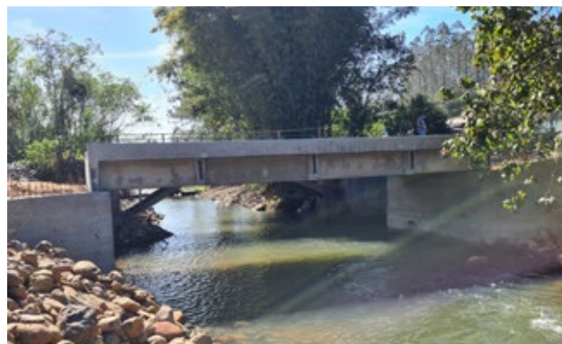
Instalação de kit de transposição Foto: ASCOM/DSC
