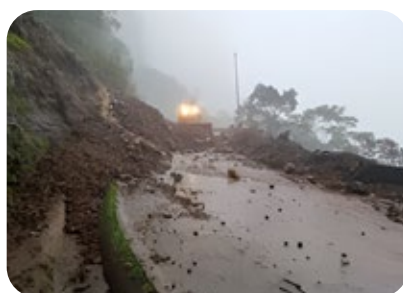
Obras emergenciais na Rodovia SC-390 (Serra do Rio do Rastro), em Lauro Müller
