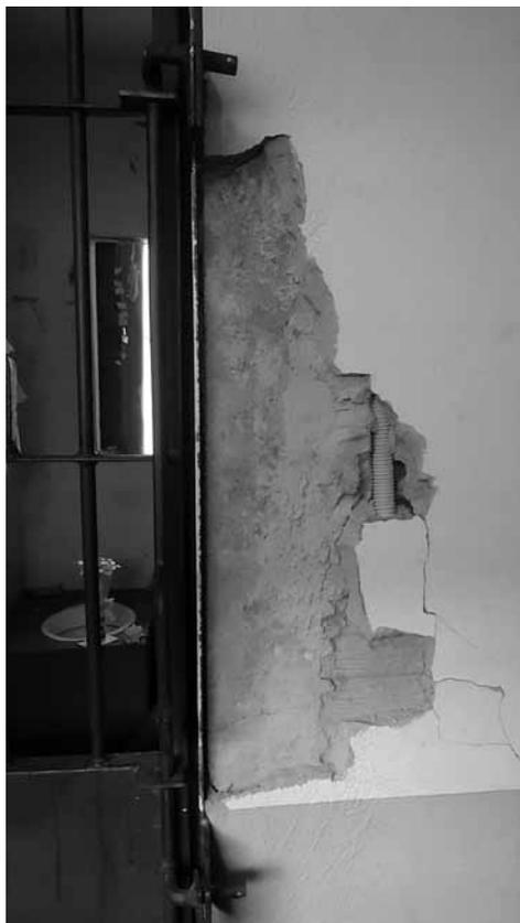
Em grande parte das paredes, o reboco encontra-se caindo, mostrando os dutos da rede elétrica
