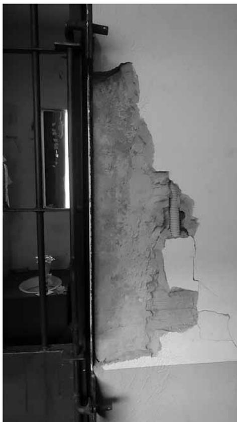
Em grande parte das paredes, o reboco encontra-se caindo, evidenciando os dutos da rede elétrica
