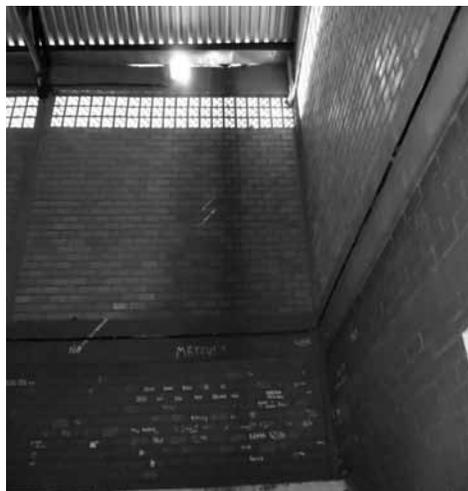
Ginásio muito comprometido com diversos vazamentos e toda a fiação elétrica exposta na EEB Almirante Lamego, Laguna
