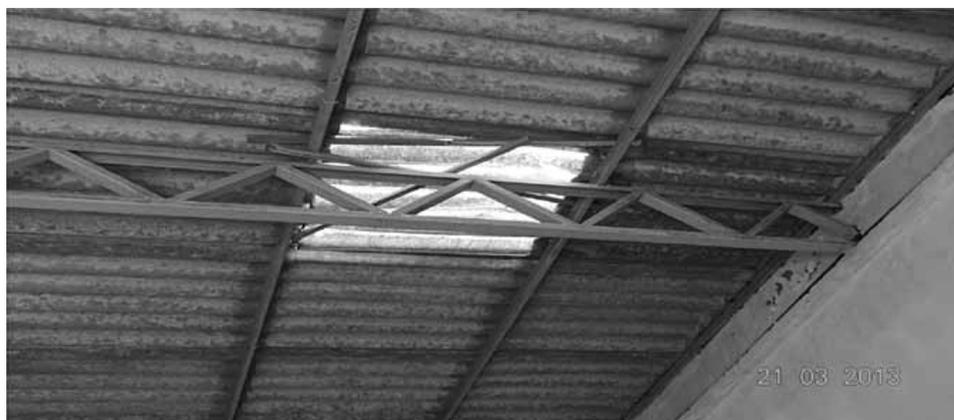
**TELHADO EXISTENTE ENTRE O GINÁSIO DE ESPORTES E PRÉDIO DAS SALAS DE AULA COM “REMENDOS” INDEVIDOS OS QUAIS PROPORCIONAM O SURGIMENTO DE GOTEIRAS NESTA ÁREA**
