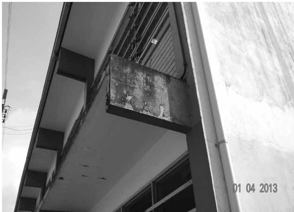
**CORROSÃO DA ARMADURA JÁ É VISÍVEL NA MARQUISE. PROBLEMA QUE DEVERÁ SER CORRIGIDO PARA EVITAR MAIOR DEGRADAÇÃO DO EDIFÍCIO**
