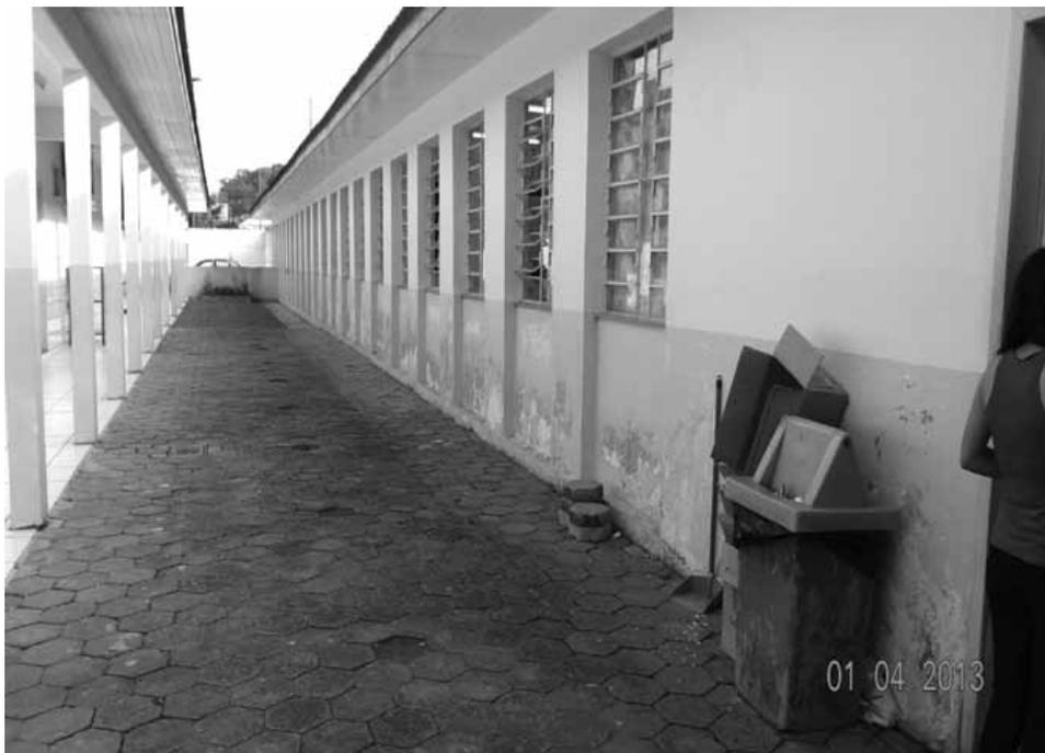
**PINTURA DA ESCOLA ENCONTRA-SE DETERIORADA. PROBLEMAS DE DRENAGEM CONTRIBUEM PARA UMIDADE NAS PAREDES**
