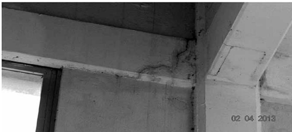
**FISSURA NOS ELEMENTOS ESTRUTURAIS PROVOCAM INFILTRAÇÕES INDESEJADAS NA EDIFICAÇÃO**
