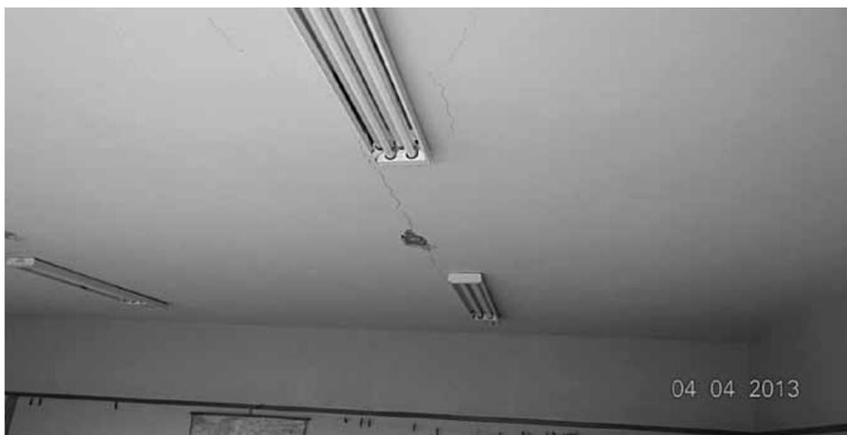
**TRINCA ACENTUADA DA LAJE DEVE-SE AO VÃO EXCESSIVO, EM FUNÇÃO DO TIPO DE LAJE ADOTADA (VIGOTA SIMPLES), EVIDENCIANDO FALHA DE PROJETO**
