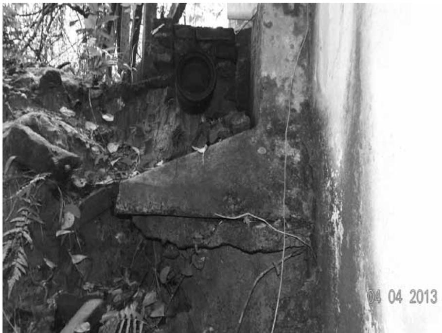
**FUNDAÇÃO FOI AFETADA PELA ÚLTIMA ENCHENTE, PORÉM AINDA NÃO FOI CORRIGIDA. CONSTATA-SE QUE A PEÇA ESTRUTURAL ESTÁ EM RISCO. SE OCORRER NOVA ENCHENTE NESTE CANTO EM QUE SE ENCONTRAM AS FUNDAÇÕES, PODERÁ OCORRER EROSÃO DO LOCAL E O CONSEQUENTE DESABAMENTO DE BOA PARTE DO GINÁSIO DE ESPORTES**
